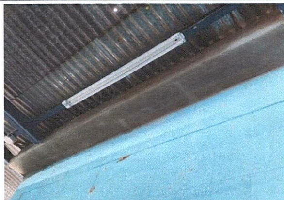
Foto 2: Mejoramiento de bajadas pluviales del establecimiento.
