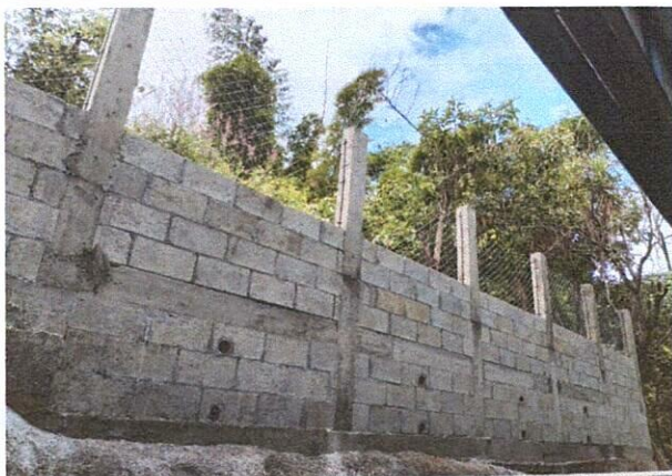
Foto 3: Mejoramiento de muro de contención parte de atrás de la escuela.
