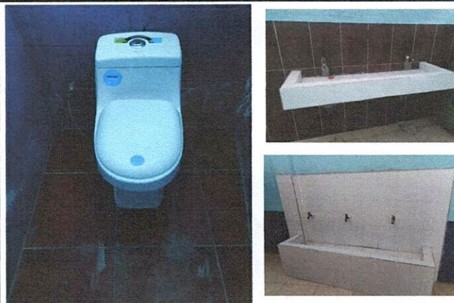
Foto 4: Mejoramiento de sanitarios del centro educativo.
